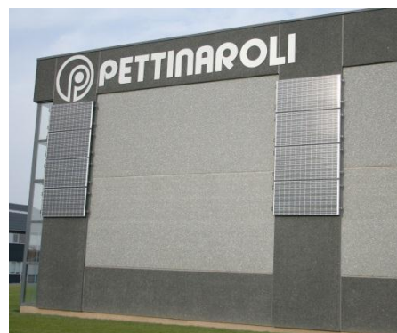
20 solcellepaneler er monteret på facaden af Pettinarolis lagerbygning. De forsyner firmaet med strøm til bl.a. drift af STIEBEL ELTRON varmepumper, som opvarmer bygningerne.
