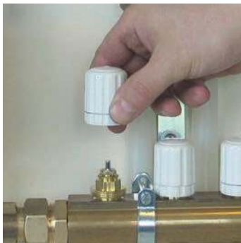
Afmonter det nederste håndgreb
