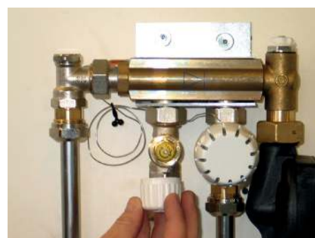
Reguleringsventilens dæksel afmonteres
