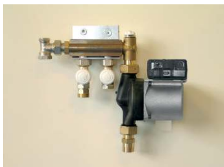
Monter minishunten på væggen.
