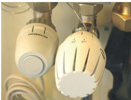
Telestaten tilsluttes styreenheden.
