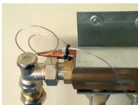
Føleren anbringes mellem blanderør og ophængsbeslag.
