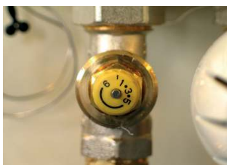
Indregulering foretages på forindstillingsskruen.
