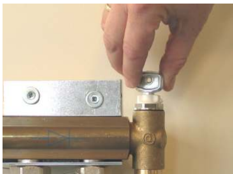
Udluftning af anlægget foretages på udluftningsskruen
