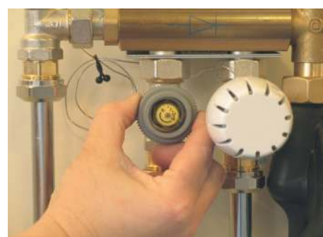
Adaptoren til telestaten monteres.
